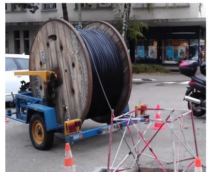
Une fois enroulés, les câbles de fibre optique vont être déployés sur le territoire jusqu'aux logements des abonnés.
